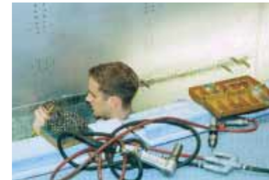
Aufwändig: Der Spengler nietet ein Fugenabdeckband der Aussenwand.
