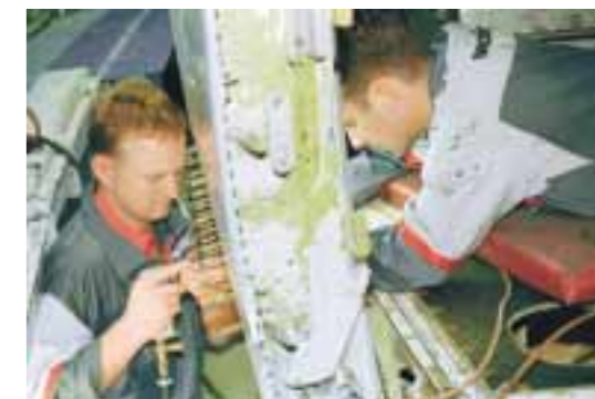
Teamwork: Reparaturarbeiten der Spengler an der vordersten Türe.
